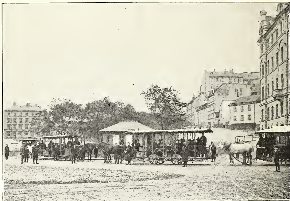
79. Spårvagnsstation vid Tegnérsgatan.
